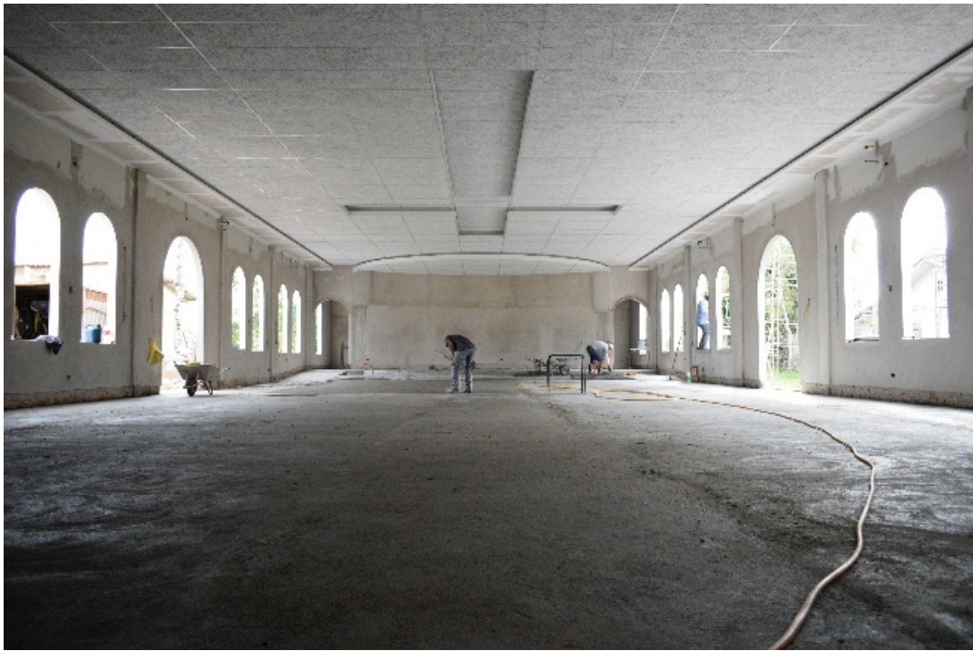
Figura 15 - Reforma da Capela Nossa Senhora Aparecida
